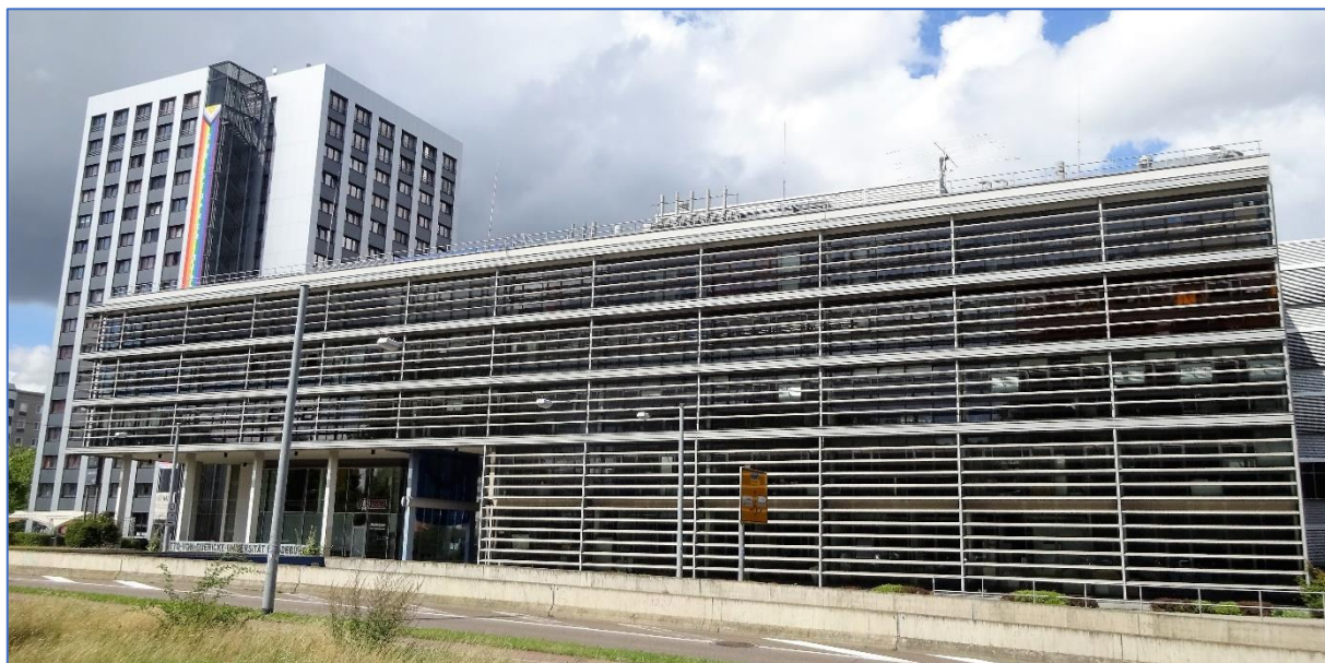
Fakultätsgebäude Elektrotechnik OvGU
